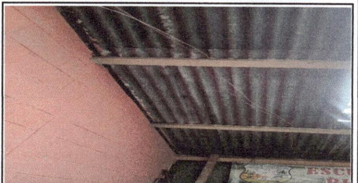
Foto 6: sustitución de estructura de techo de madera por estructura de metal
